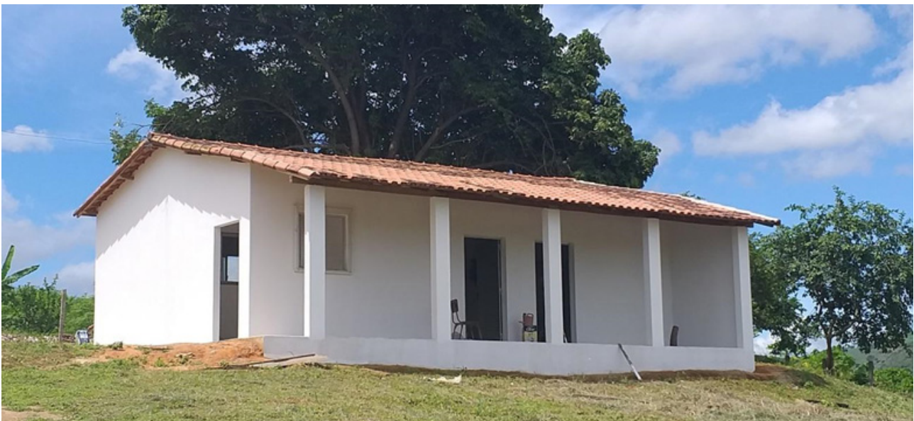
Imagem 7 - Abatedouro após as reformas e adaptações exigidas pelo SIM de Colatina.
