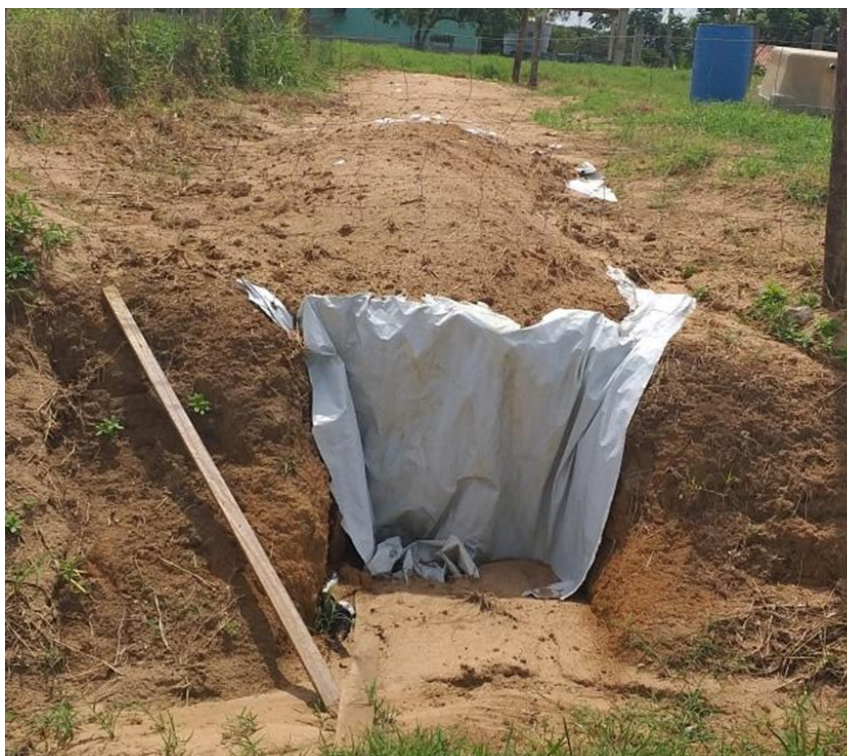
Imagem 1 - Silo não revestido para estocagem de silagem de milho reidratado (capacidade 11 ton de milho moído).
